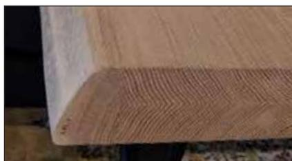
mit der selben Lamelle aufgedoppelt
